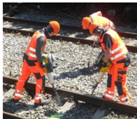
Bensinhammerne BH40 og BH55rw er optimalisert spesielt for vedlikeholdsarbeid ved jernbanekonstruksjon.
